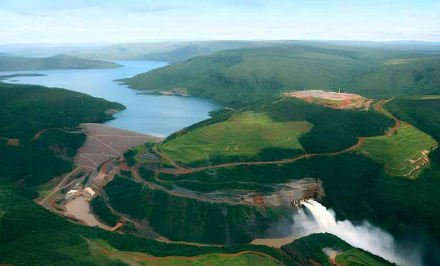
Usina Hidrelétrica de Irapé, MG
