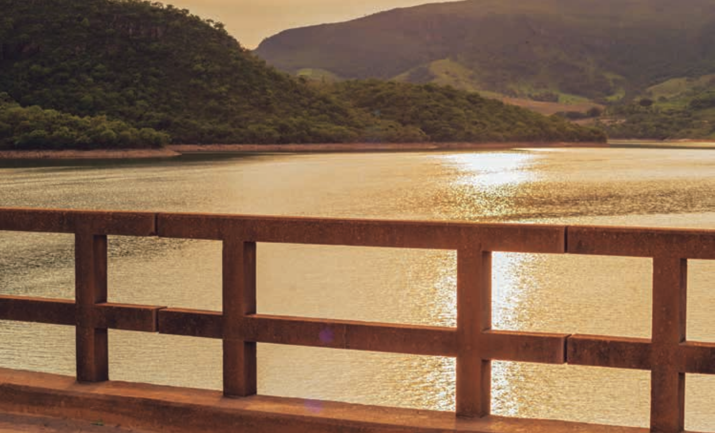
Guapé, MG, vista da Ponte de Santo Hilário
