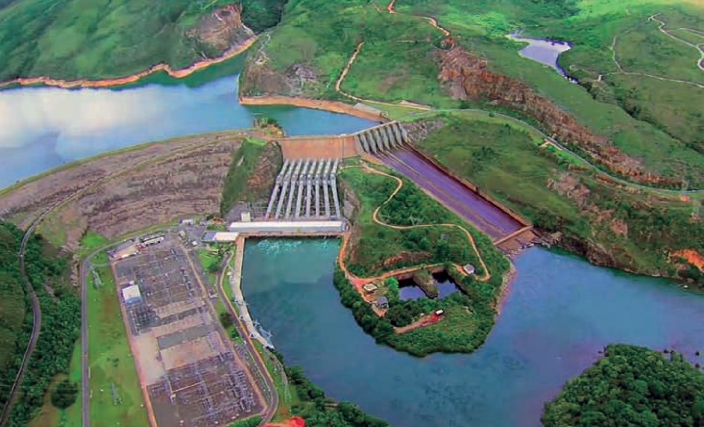
Represa de Furnas, São José da Barra, MG
