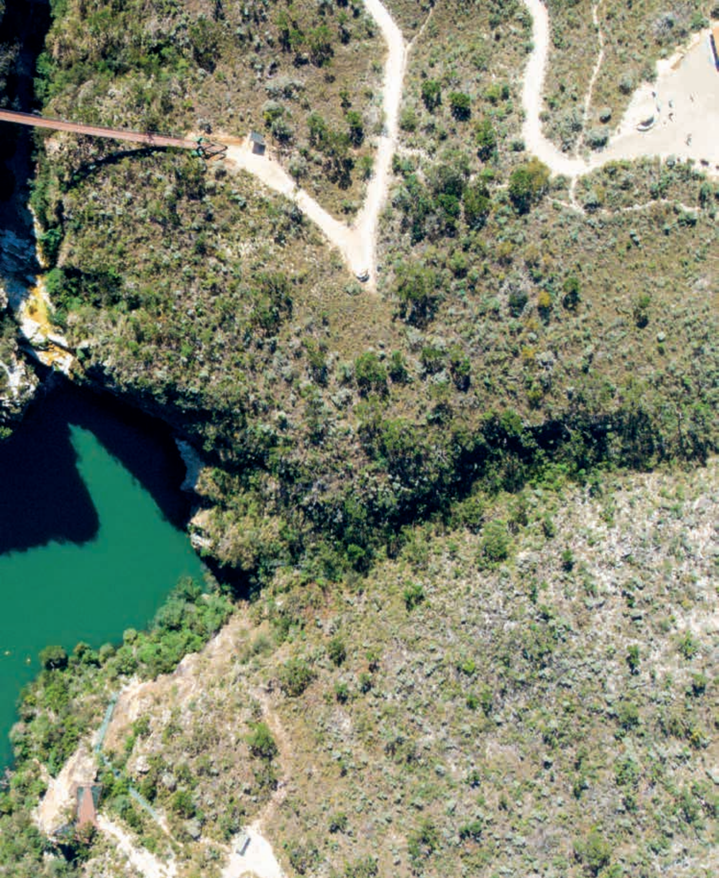
Vista aérea do Eco-parque Mirante dos Canyons Cataguá, Capitólio, MG
