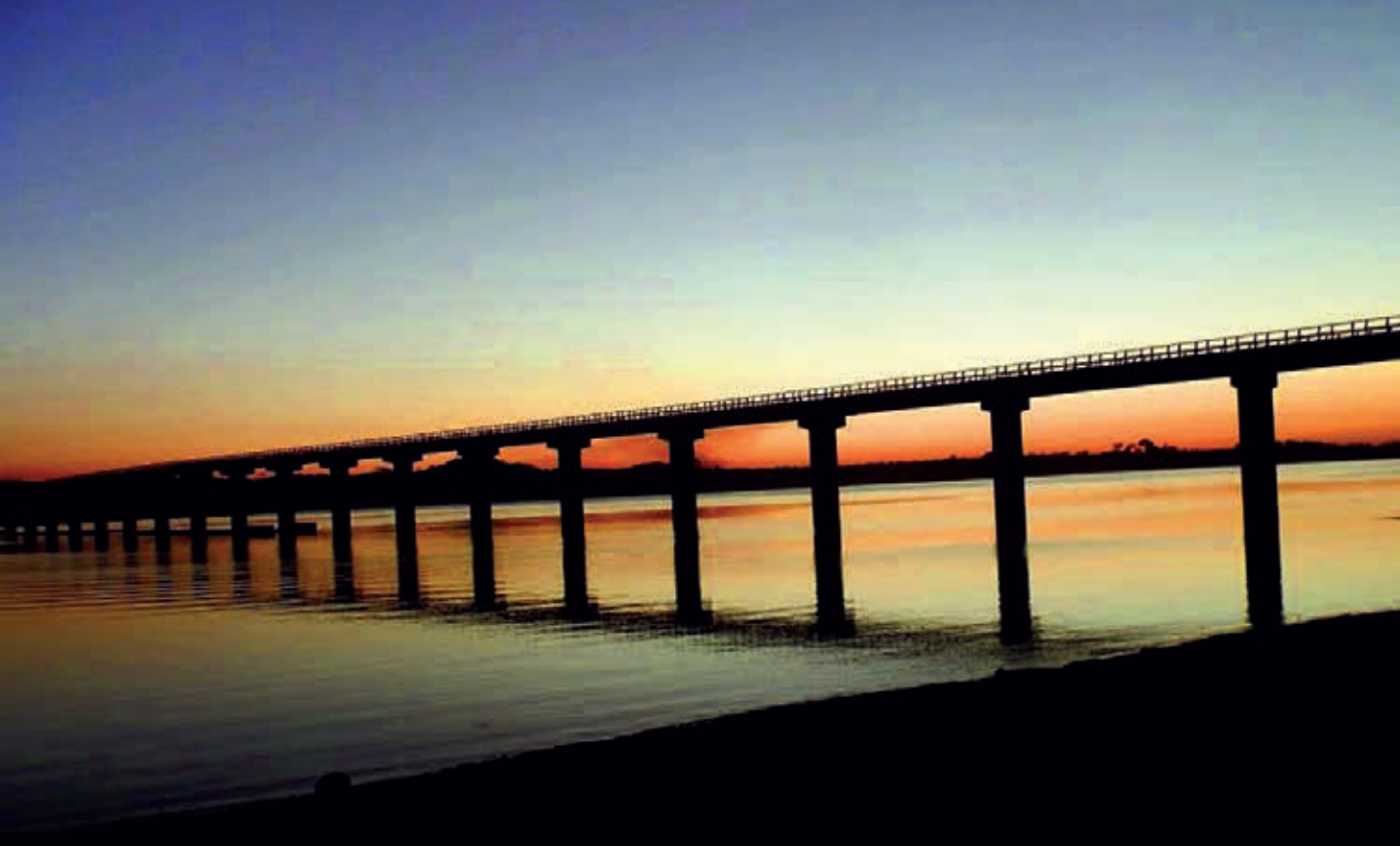
Ponte das Amoras, Alfenas, MG
