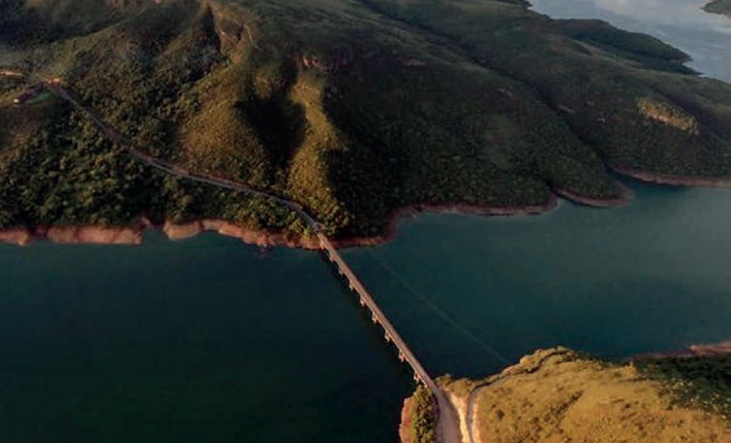
Ponte de Santo Hilário, Pimenta, MG
