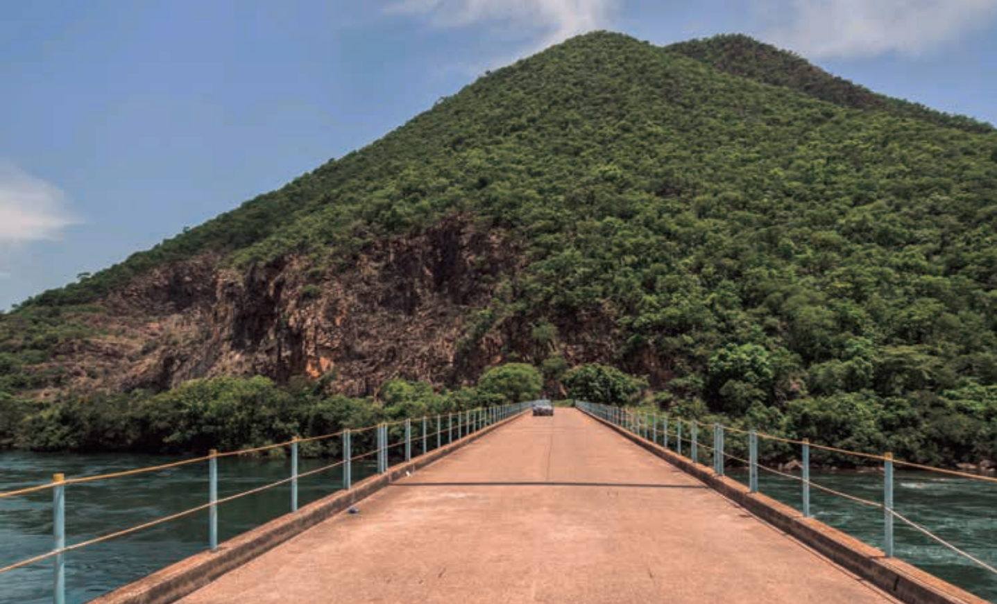
Ponte dos Peixotos, Ibiraci, MG
