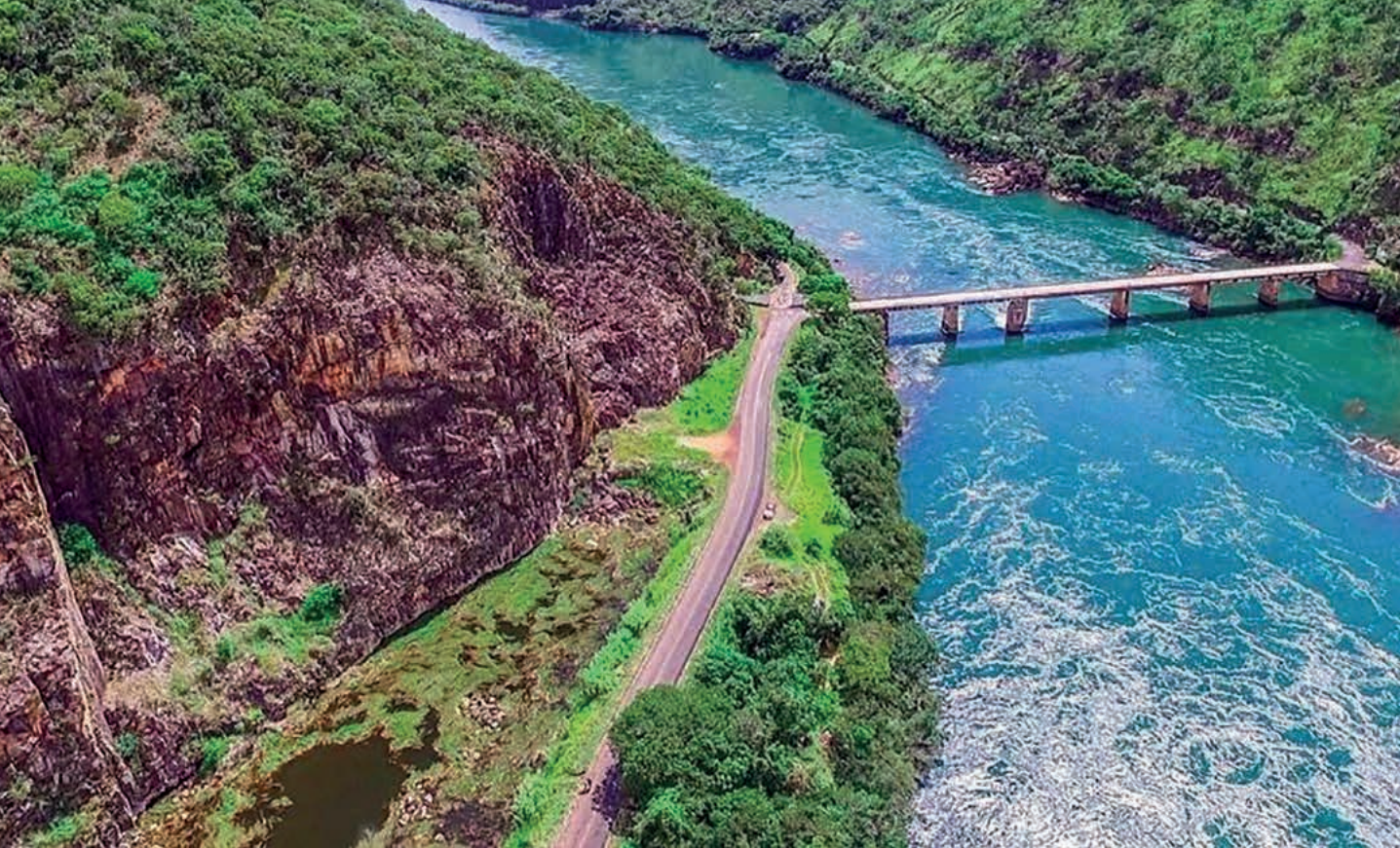
Ponte dos Peixotos, Ibiraci, MG
