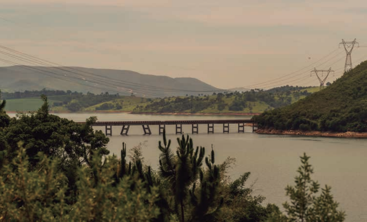
Ponte Torta, Carmo do Rio Claro, MG
