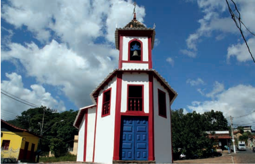
Capela de Nossa Senhora do Ó - Sabará - MG
