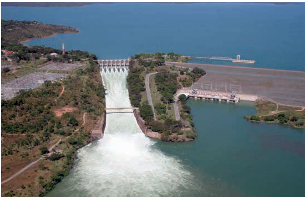
Reservatório de Três Marias - Três Marias - MG
