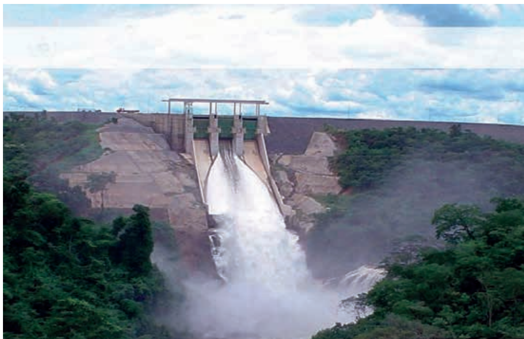
Usina Hidrelétrica Queimado - Unaí - MG
