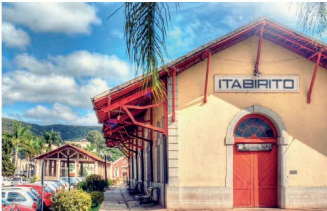
Antiga Estação Ferroviária - Itabirito - MG
